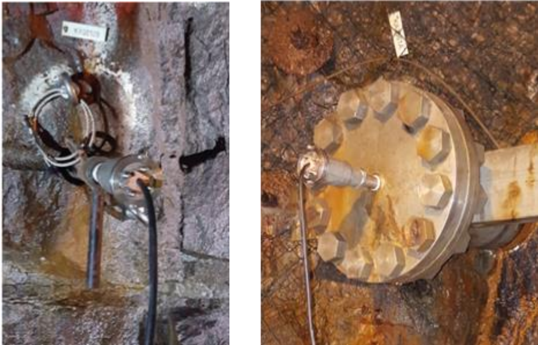
Figur 9-3, Borrhål med installerade prover och korrosionsgivare. Till vänster: borrhål B. Till höger: borrhål A.
